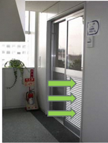
入り口にガラの設置
