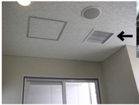
天井に排気口
