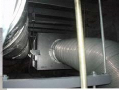
天井裏に排気装置を増設
